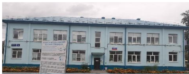
Корпус по адресу мкр. Южный, 4- 199 воспитанника
